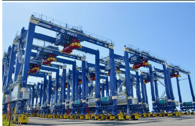
遠隔操作・電動RTG
