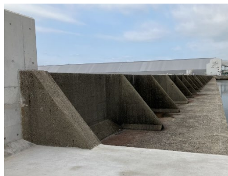
上部工の嵩上げ（整備前）
