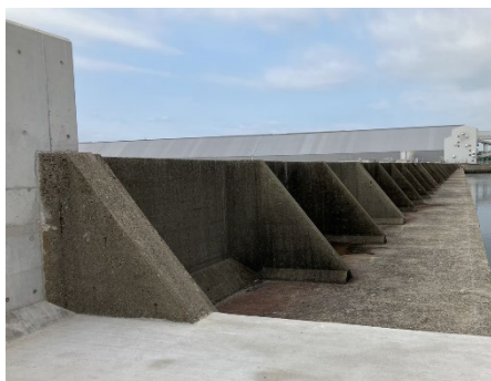
上部工の嵩上げ(整備前)
