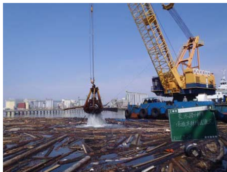
図 18 石巻港における浮遊物揚収状況
