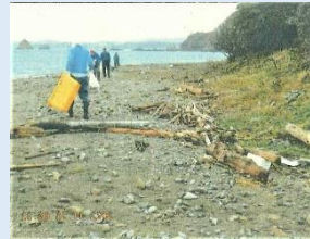
浮遊・堆積物の除去
