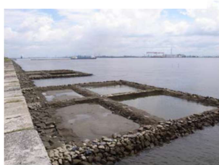
(b) 名古屋港内における実証試験
