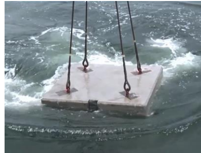
写真3.人工石の投入状況
