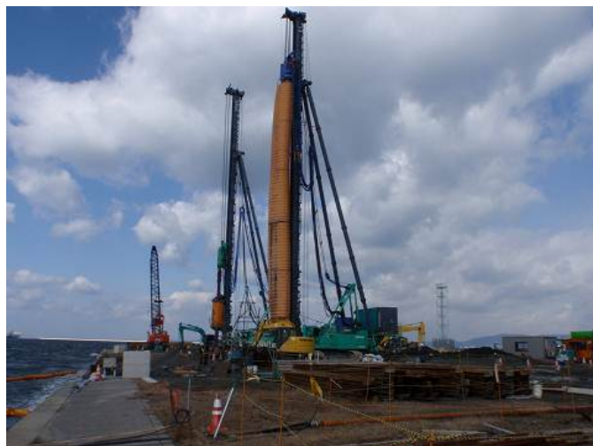
地盤改良状況
