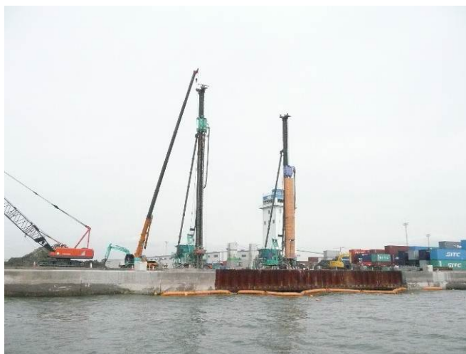
施工状況全景
