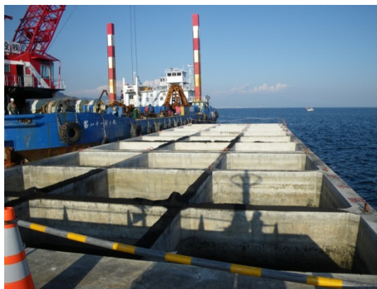
⑥ケーソンを据付します
