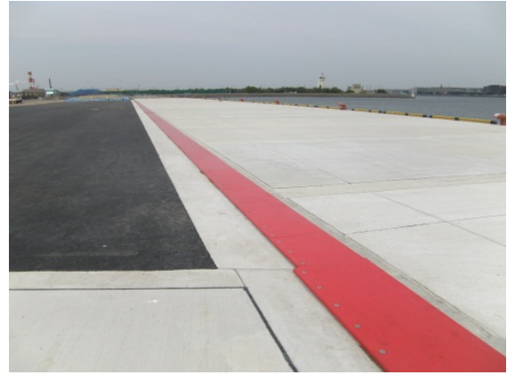
隣接工区の完成した状態
