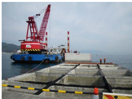
⑤ケーソンの据付位置を調整します
