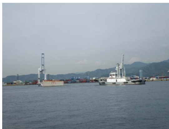
④ケーソンを据付場所まで曳航します
