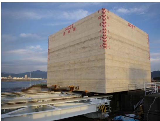
①ケーソンを横引きして台車に載せます
