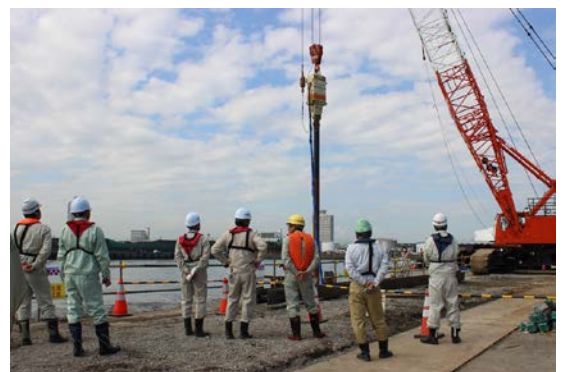
【施工中の現場で見学会】
