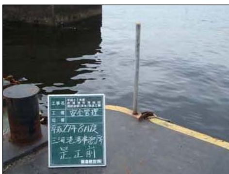
【是正前：平台船にも救命浮環設置必要】
