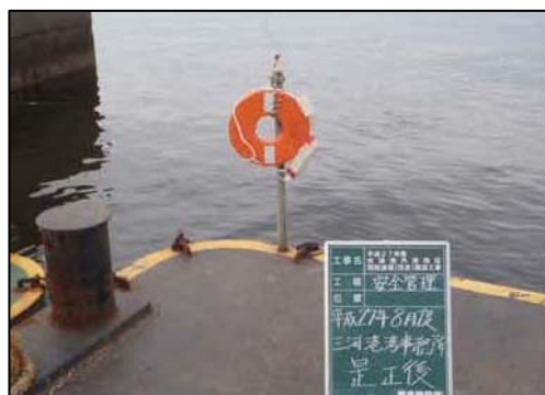
【是正後：救命浮環を設置】
