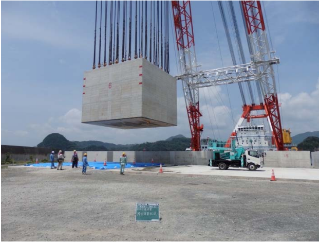
コンクリートブロック吊上げ
