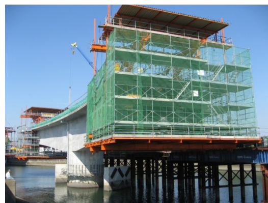
【現場の状況(H28.10時点)】
