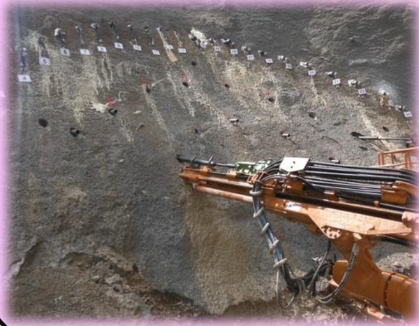
←掘削する前に地山を固める作業をしています。しばらくはこの作業を繰り返しながら作業を進めていきます
