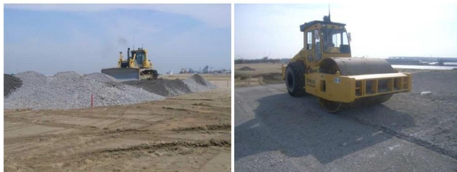
④敷き均しおよび転圧
