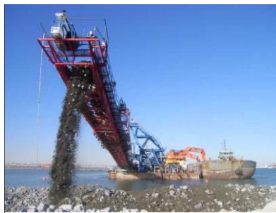
②揚土船を用いた土砂投入
