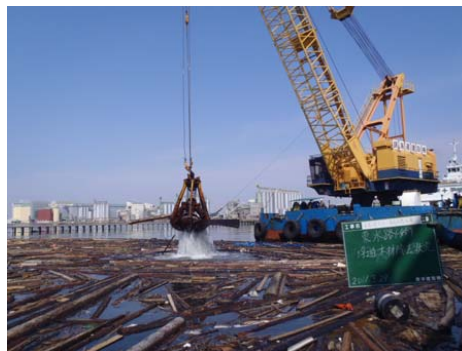
図 23 石巻港における浮遊物揚収状況
