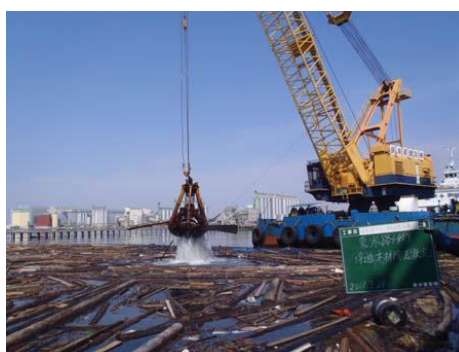
図 19 石巻港における浮遊物揚収状況
