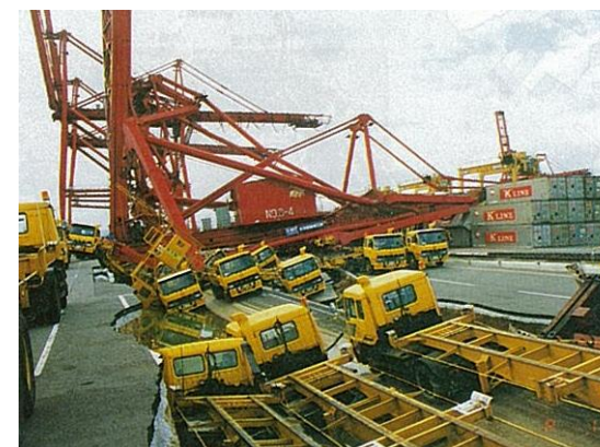
六甲アイランドにおける被災状況
