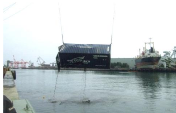
【航路啓開の状況】 （コンテナの引き揚げ）
