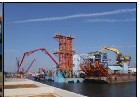
④ケーソン補強の完了後、防波堤の嵩上げ、洗掘防止及び上部工前面の補修を実施
