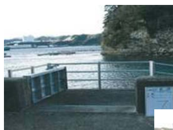
代替通路(階段)により陸閘を廃止した事例(和歌山県)
