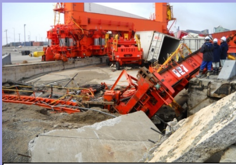
荷役機械の倒壊により荷役不能 となった岸壁(仙台塩釜港)
