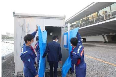
プレハブの設置
