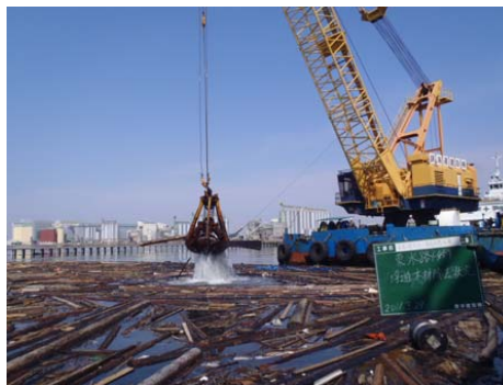
図 19 石巻港における浮遊物揚収状況
