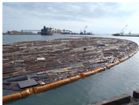
図 15 石巻港における浮遊物封じ込めの状況
