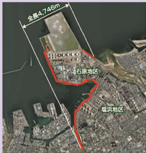
四日市港海岸（石原・塩浜地区）
