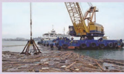
浮遊物・障害物除去作業
