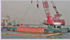
コンテナ撤去作業
