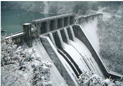
ダム内部や操作室を見学できます！
