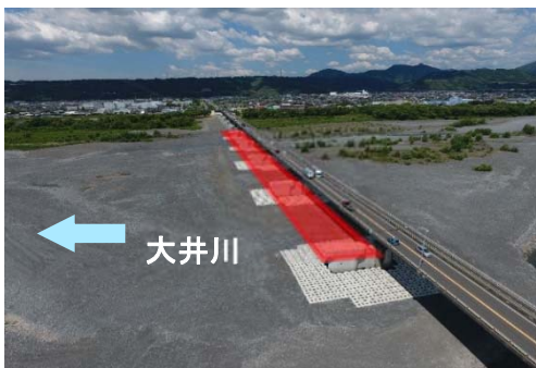
橋を架ける工事を見学できます！
