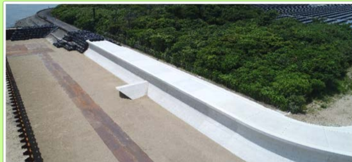
完成した海岸堤防(津地区栗真町屋工区)
