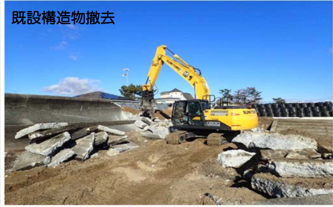
海岸堤防整備状況(2019年6月～2019年8月頃予定)
