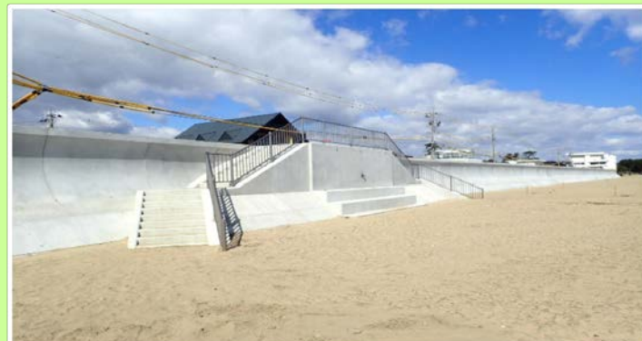
完成した海岸堤防(津地区阿漕浦・御殿場工区)
