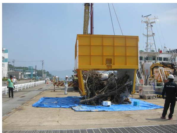
回収物陸揚げ状況
