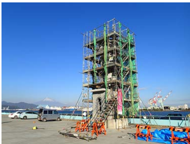
<灯台製作状況>
