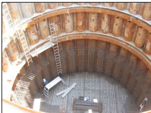
【①頂版結合(鉄筋スタッド)施工状況】
