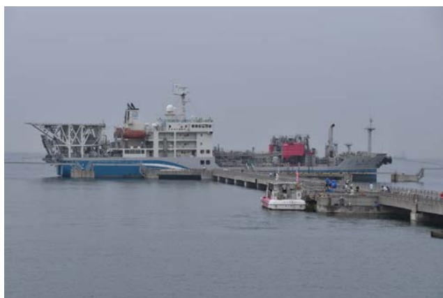
夕日棧橋への着岸状況
