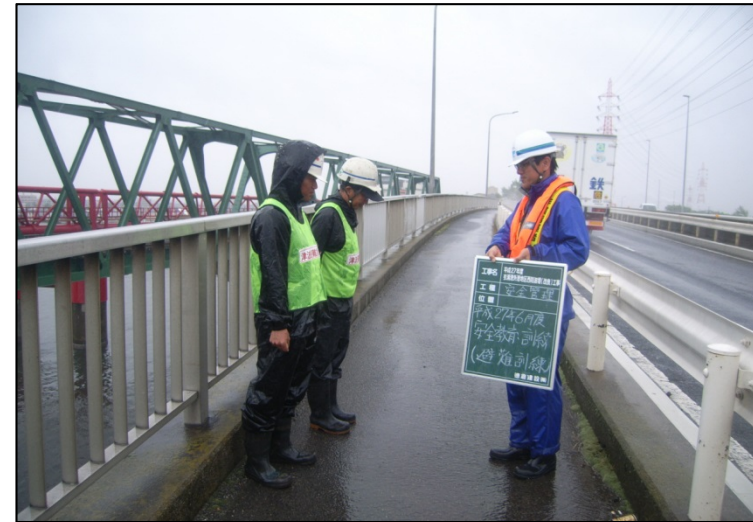
「臨港道路武豊線架橋」に到着、「全員無事か」点呼している様子
