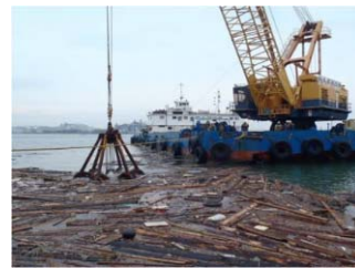
作業船による揚収物除去作業の様子
