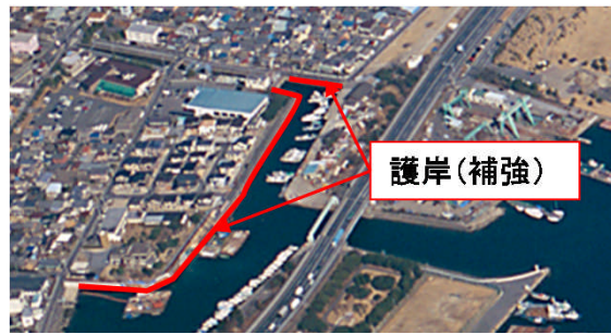
富田港地区護岸の補強
