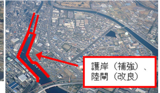
半田地区海岸保全施設の改良
