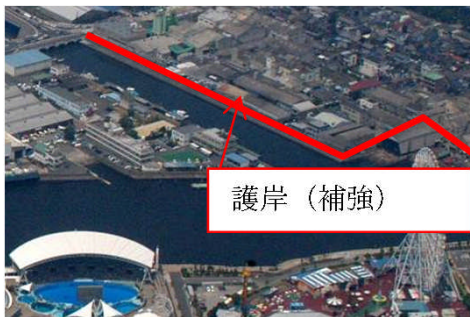
大手ふ頭地区護岸 液状化対策
