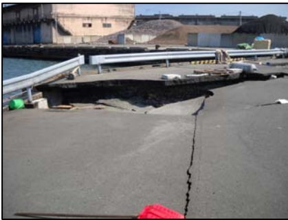
東ふ頭のアスファルト舗装が被災
