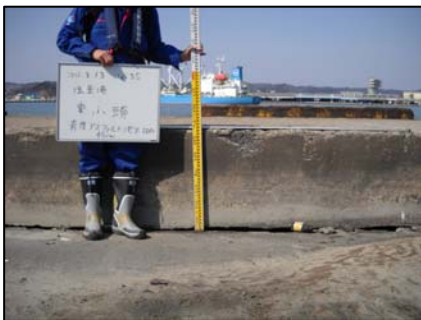
東ふ頭の背後アスファルト舗装が広範囲にわたり沈下
