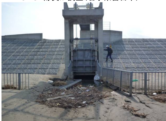
津波により土砂が堆積し、水門から流れる箇所を閉塞し、住宅地側からの排水が出来ない状況<阿武隈川河口付近右岸 荒浜排水樋管(手前が河川)>(宮城県大崎市)
