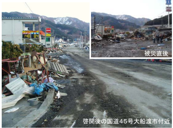
支援物資輸送等の拠点となる港湾と周辺地域を結ぶ道路を発災後すぐに啓開
