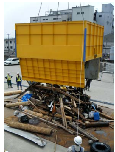
回収した漂流物を仙台塩釜港で陸揚げしている状況
