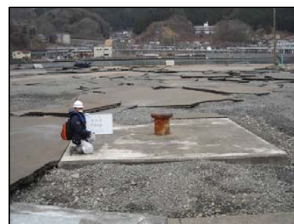
須賀地区ふ頭のアスファルト舗装版が広範囲にわたり被災(中央部は岸壁の係船柱)
