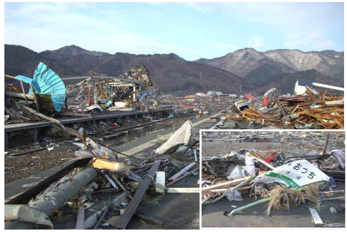
大槌町内の被害状況(JR大槌駅)
