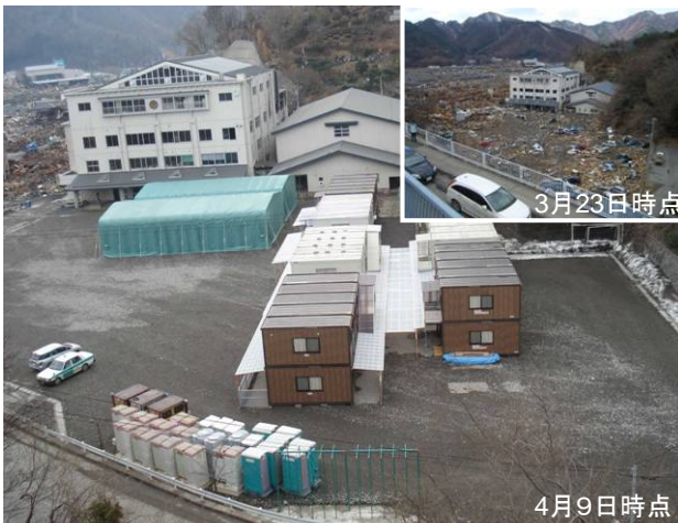
津波により使用不能となった役場の代替となった仮庁舎が完成
