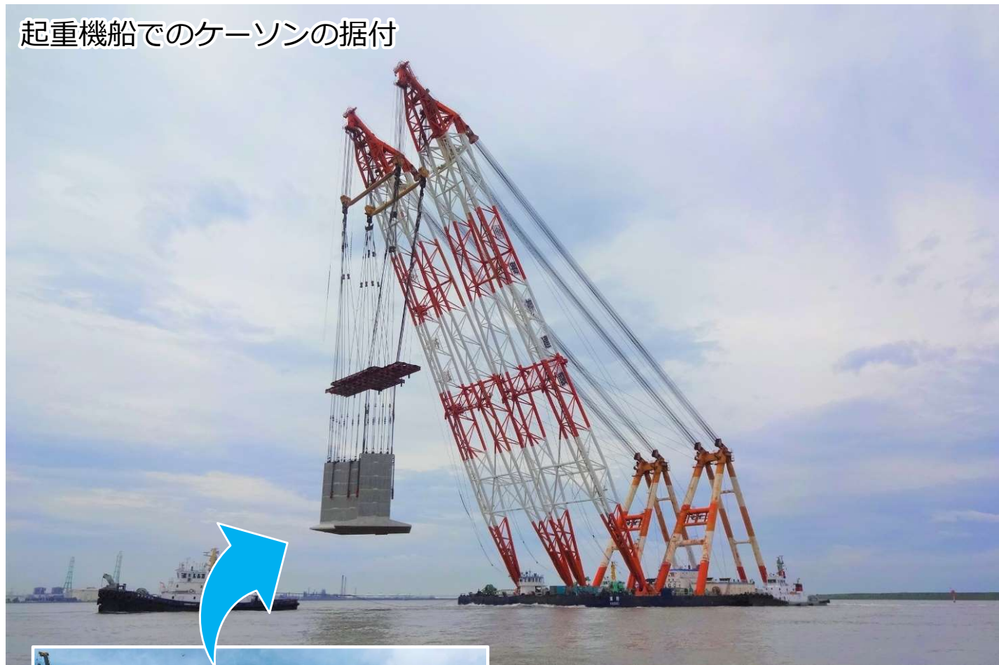
据付前のケーソン
