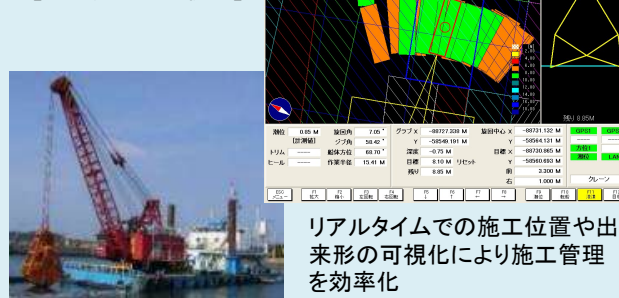
【施工箇所の可視化】
