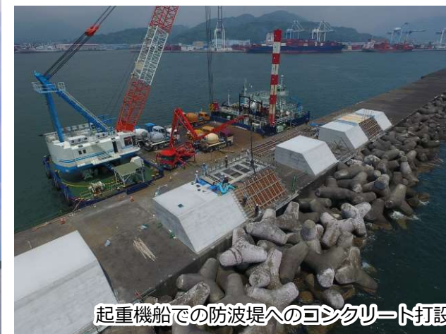
起重機船での防波堤消波ブロック据付
