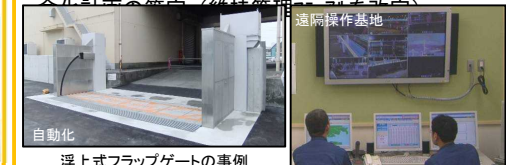
浮上式フラップゲートの事例（徳島県撫養港）
