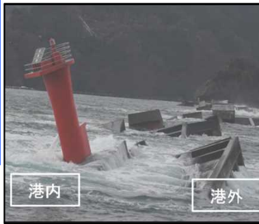
釜石港の湾口防波堤被災状況
