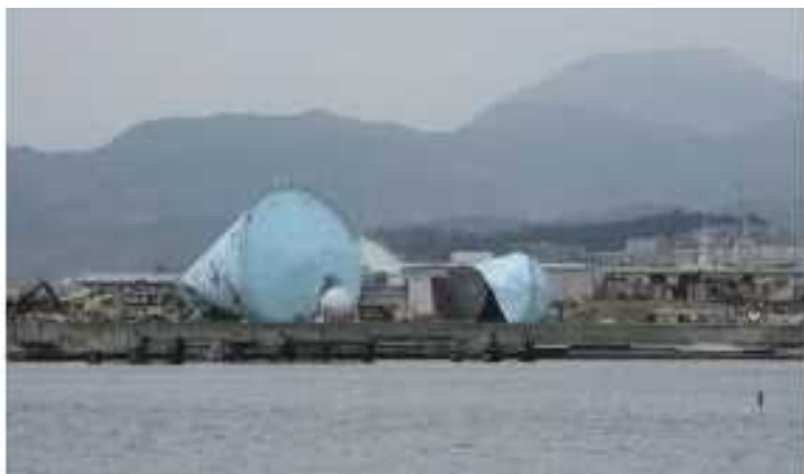
津波により被災したタンク
