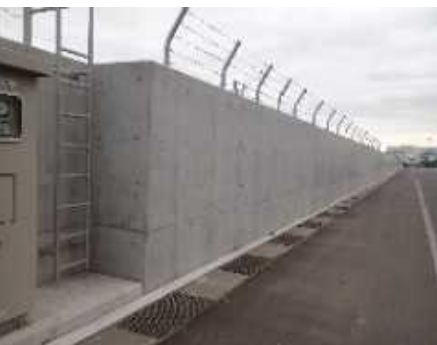
SOLASフェンス基礎部の強化
