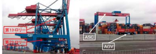
ダブルトロリー方式ガントリークレーン ※第2トロリーは、完全自動化 AGV(自動搬送台車)と ASC(自動スタッキングクレーン)
