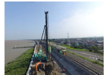
木曾川津波対策耐震事業
