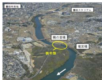
矢作川 うくび の首地区水位低下対策事業
