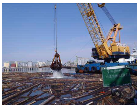
図 18 石巻港における浮遊物揚収状況
